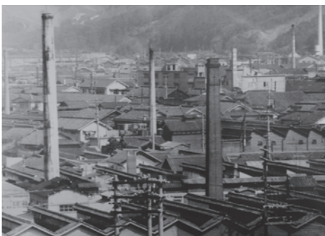
煙突とノコギリ屋根の播州織工場が立ち並ぶ(昭和40年代)
